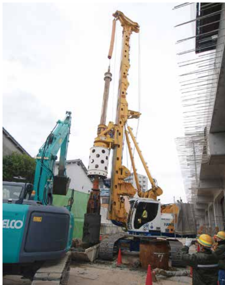
BG 掘削近接工事
